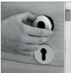
Einbau der Rosetten am Türblatt.
